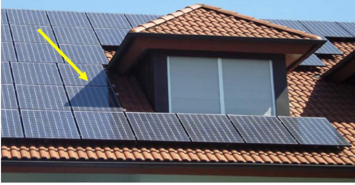
Şekil 1. Gölgeleme Kayıplarına Maruz Kalan Güneş Paneli (Kırbıyık, 2023)
