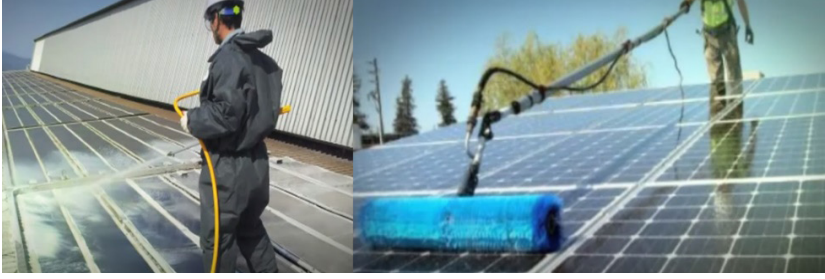
Şekil 4. İnsan Gücü ile Temizleme Örneği (Sadece su ile temizleme (solda) - temizlik materyalinin insan yardımı ile kullanılması (sağda))
