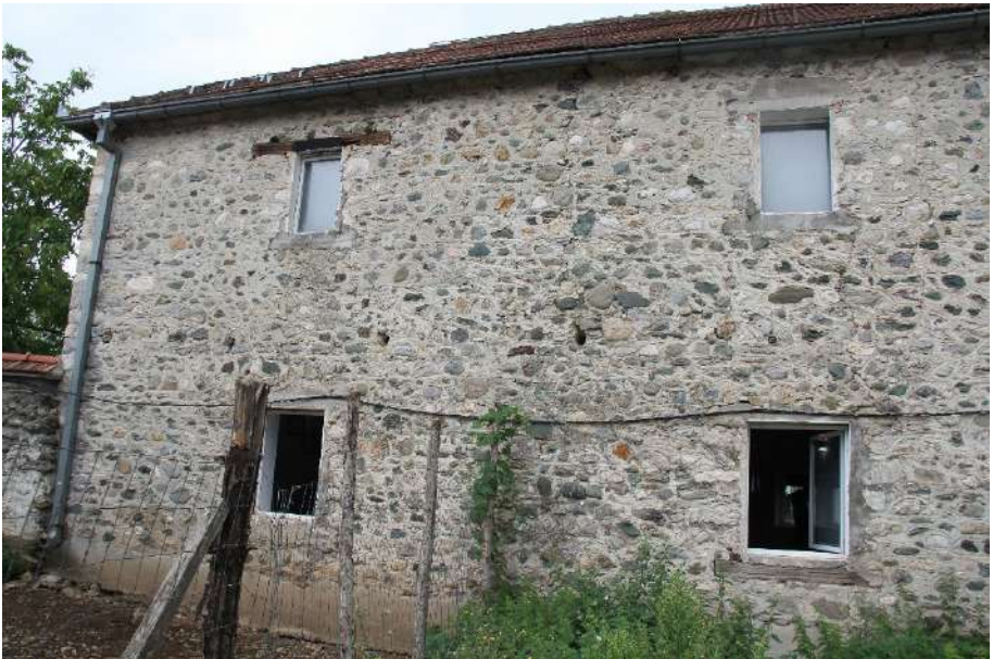
Foto 52. Çarabreg Köyü Camisi, doğu cephe.
