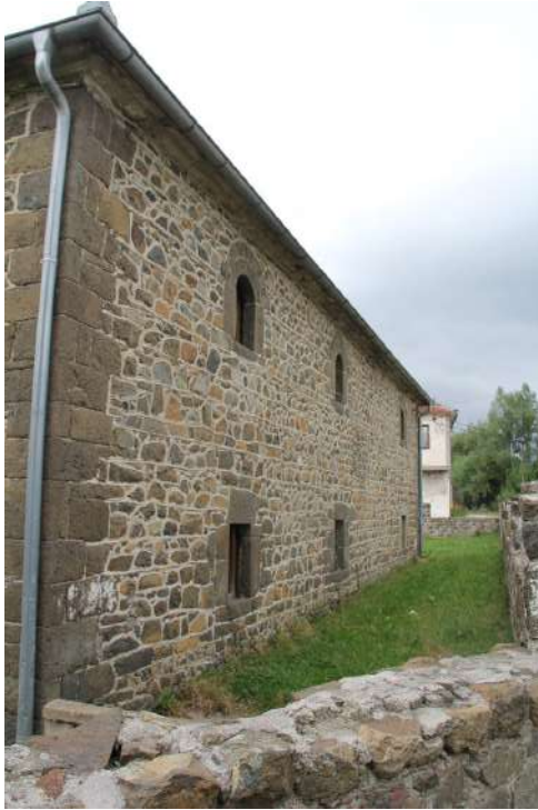
Foto 70. Babaloç Köyü Camisi, doğu cephe.
