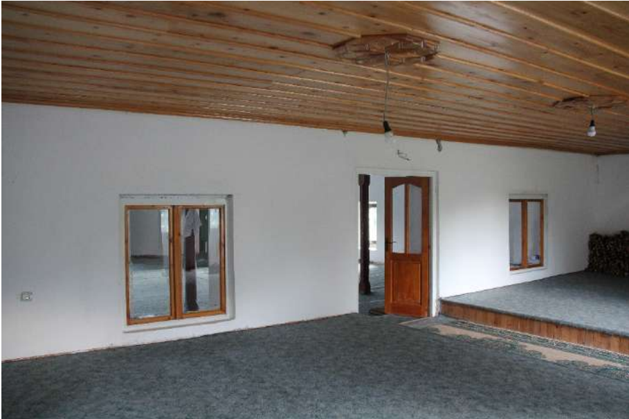
Foto 156. Yunik Çokun Camisi, giriş mekânı, alt kat, kuzey duvarı.
