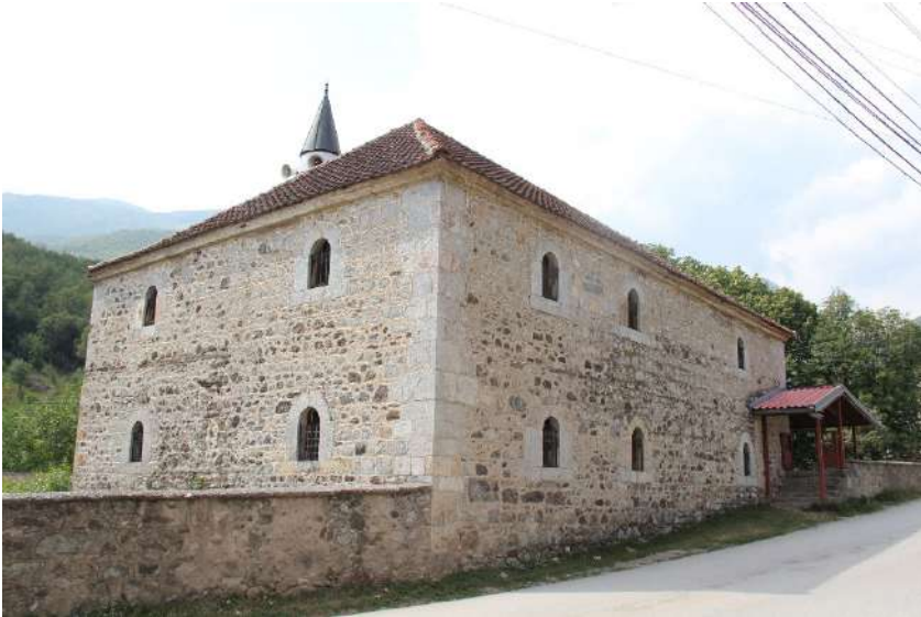
Foto 133. Büyük Yablaniça Camisi, güney doğu cephe.
