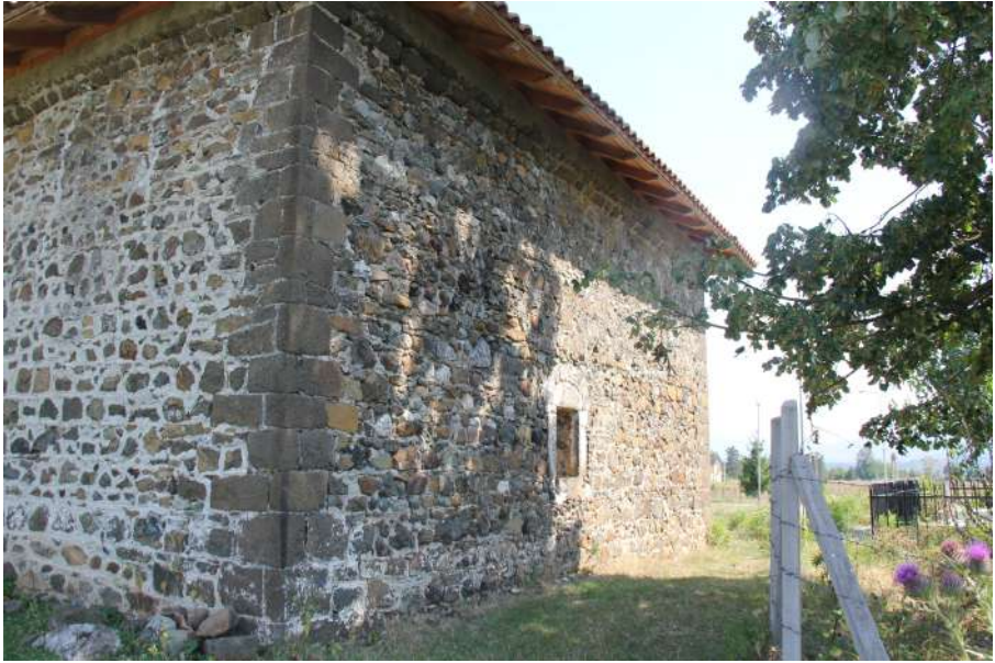
Foto 124. Smoliça Köyü Camisi, batı cephe.
