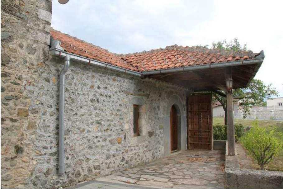
Foto 113. Pojaran Köyü Camisi, doğu cephenin kuzeyi.
