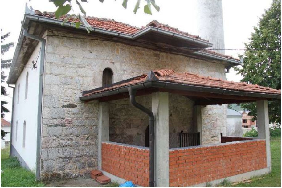
Foto 87. İpek Lubeniç Köyü Cami, kuzeydoğu cephe.
