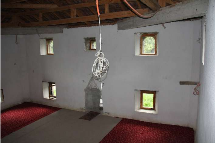
Foto 74. Babaloç Köyü Camisi, harim güney duvarı.
