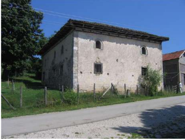
Foto 168. Vokşi Köyü Camisi, güneybatı cephe 151 .
