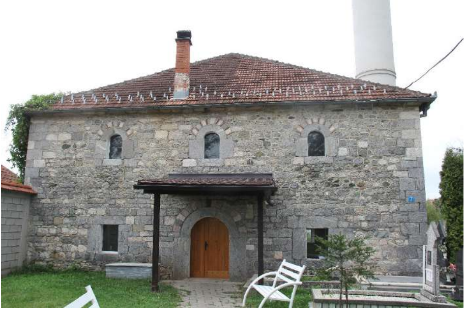
Foto 50. Çarabreg Köyü Camisi, kuzey cephe.
