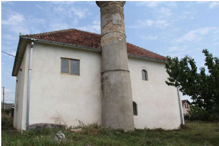
Foto 97. İpek, Kaliçan Camisi, batı cephe.
