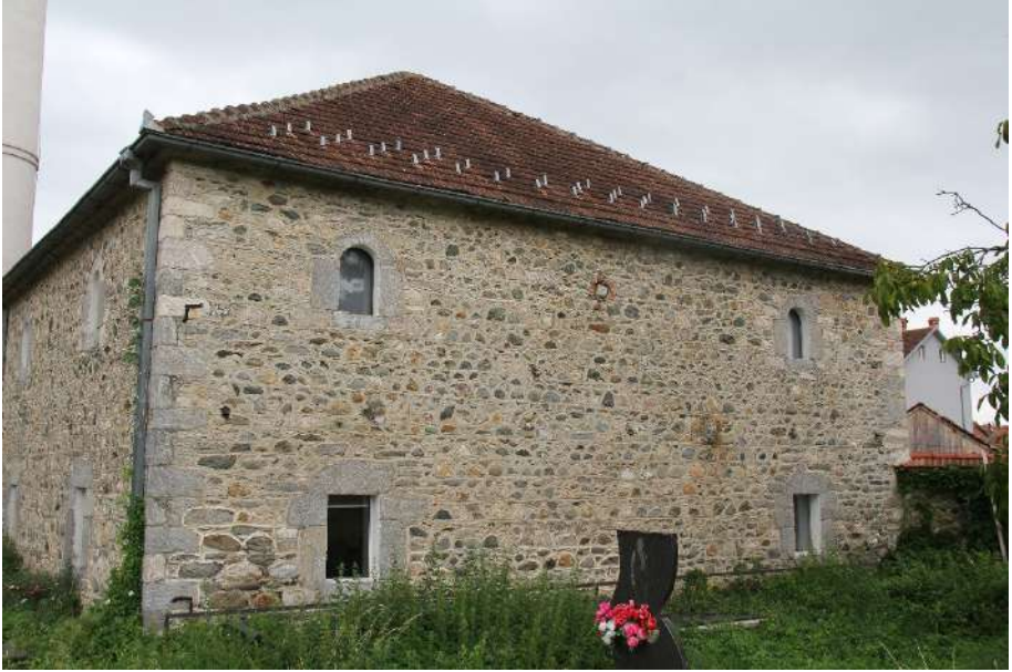
Foto 51. Çarabreg Köyü Camisi, güney cephe.
