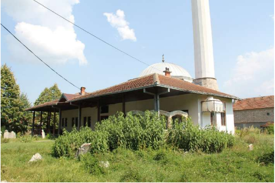
Foto 1. Yakova, Rugova Köyü, Hasan Ağa Camisi, kuzeybatı cephe.
