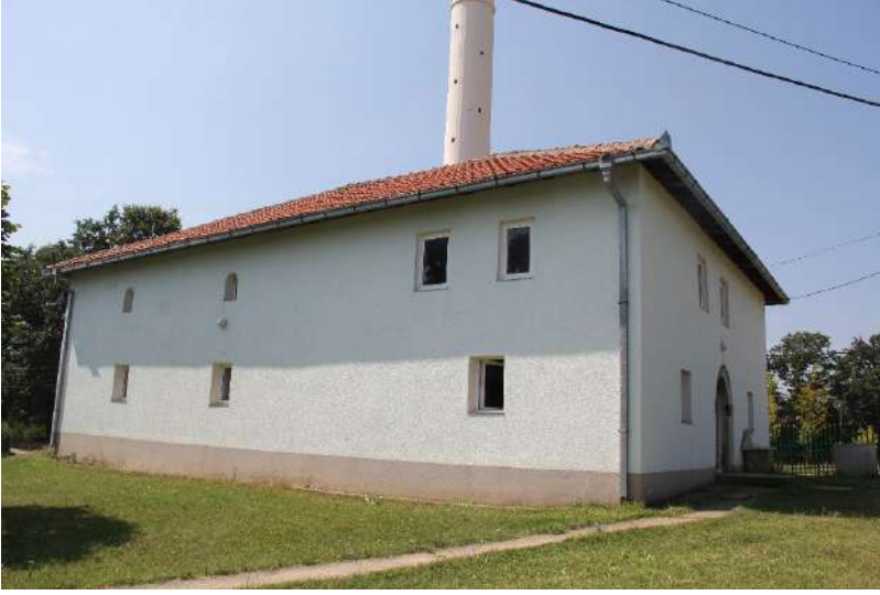
Foto 38. Babay Bokş Köyü Camisi, kuzeydoğu cephe.
