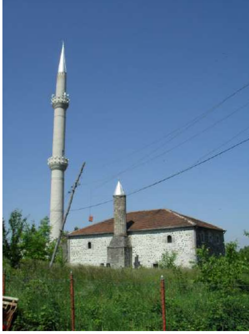
Foto 146. Yunik Çokun Cami, güneybatı cephe.
