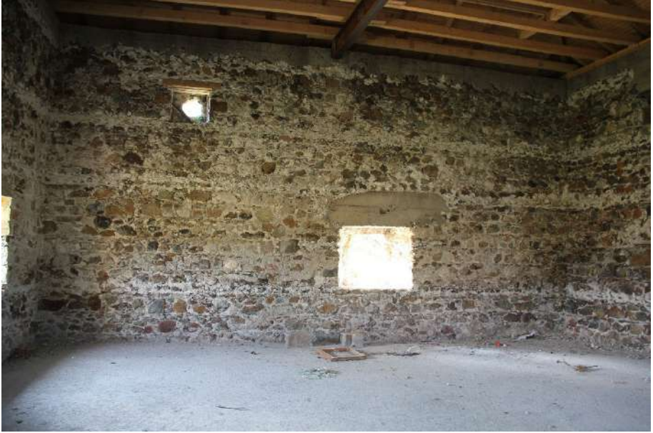
Foto 127. Smoliça Köyü Camisi, harimin batı duvarı.
