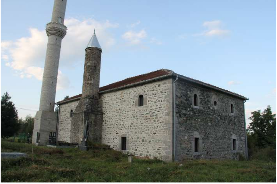
Foto 145. İpek Yunik Çokun Camisi, güneybatı cephe.
