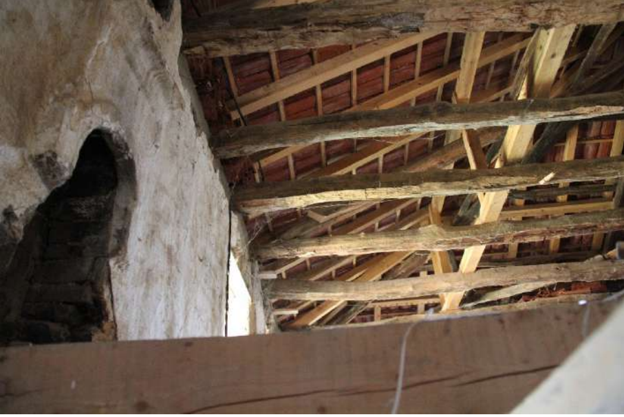
Foto 46. Babay Bokş Köyü Camisi, giriş mekânının üst katı, kuzey duvarın batısı.
