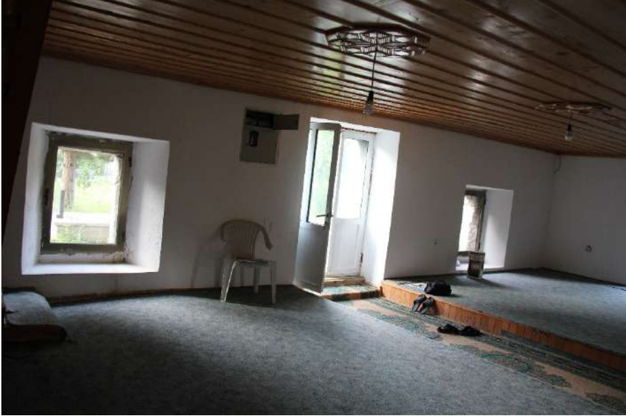
Foto 155. Yunik Çokun Camisi, giriş mekânı, alt kat, güney duvarı.
