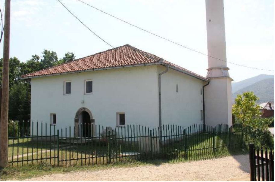
Foto 37. Babay Bokş Köyü Camisi, kuzeybatı cephe.
