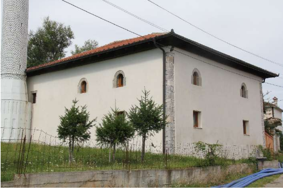
Foto 172. Vokşi Köyü Camisi, güneybatı cephe.
