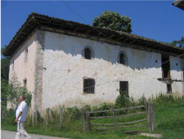
Foto 169. Vokşi Köyü Camisi, güneydoğu cephe 152 .
