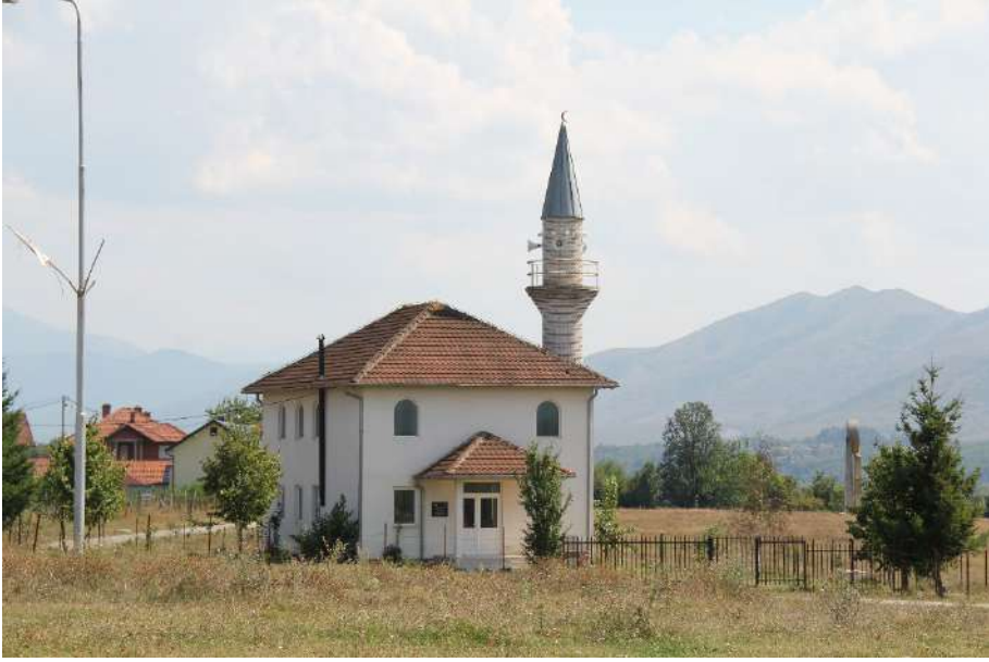
Foto 121. Smoliça Köyü Camisi, Kuveyt Yardım Komitesi'nin inşa ettirdiği yeni yapı.
