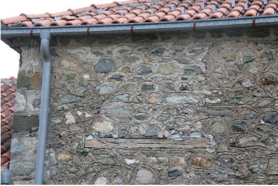
Foto 112. Pojaran Köyü Camisi, batı cephenin kuzeyinde kapatılmış pencereye ait izler.
