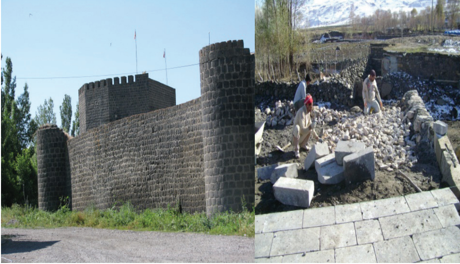
Şekil 5.6. Muş/Malazgirt Kalesi Sur Duvarları ve Muş/Varto Kaynarca Köprüsü Zemin Kaplamasında Bazalt Taşı Kullanma Görünüşleri (Öztürk, 2013).
