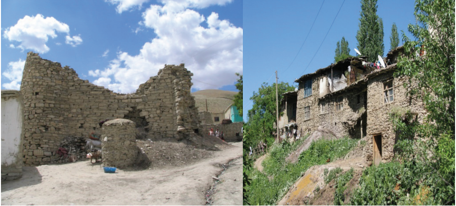
Şekil 10,11. Van Kırsal Mimaride Kayrak Sal Taşı Duvar Yapım Görünüşleri (Öztürk, 2014).
