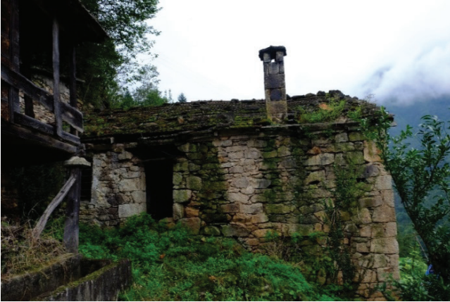
Şekil 6. Taş yapım sistemi örneği (moloz taş)
