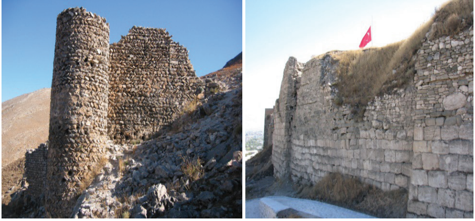
Şekil 47,48. Moloz Taşı Sur Duvarı ve Beden Duvarı Kullanım Görünüşleri (Öztürk, 2014).
