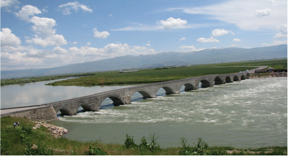
Şekil 57. Tarihi Muş Murat Köprüsü'nde Bazalt Taş Kullanım Görünüşü (Öztürk, 2022).
