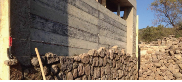
Şekil 5: Barbaros Evi'nde betonarme taşıyıcı sistem ile doğal taşın bir arada kullanımı
