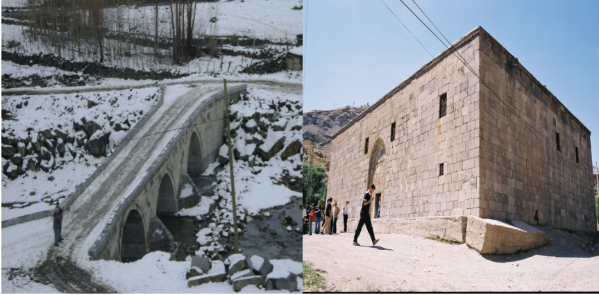
Şekil 16,17. Muş/Varto Kaynarca Köprüsü ve Hakkâri Meydan Medresesi Andezit Taş Kullanımı Görünüşleri (Öztürk, 2013-14).
