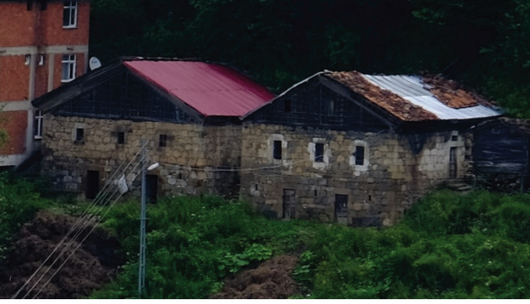
Şekil 7. Taş yapım sistemi örneği (kesme taş)
