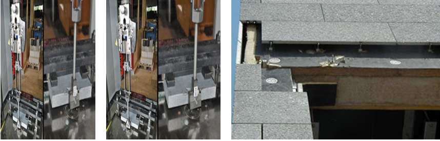
Şekil 2. Ankraj Saplama Deliğinde Kırılma Yükü Testinin Yapılması ve Mekanik Olarak Sabitlenmiş Cephe Kaplaması (URL 3, 2023)
