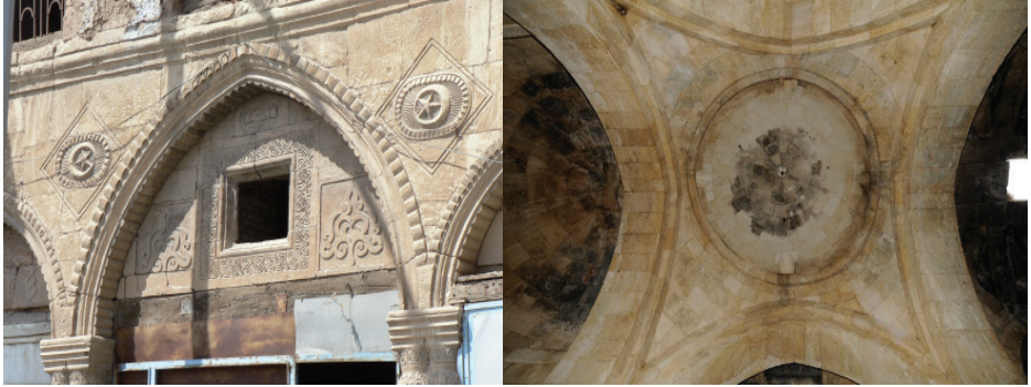
Şekil 21,22. Muş Merkez Yıldız Han Giriş Cephesi ve Van Çarpanak Manastırı Jamaton Bölümü Kubbe Kalker Taş Kullanım Görünüşleri (Öztürk, 2013).
