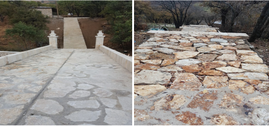
Şekil 14,15. Hakkâri/Şemdinli Taş Köprüsü Döşeme Kaplamasında Kullanılan Kayrak Sal Taşı Görünüşleri (Öztürk, 2016).
