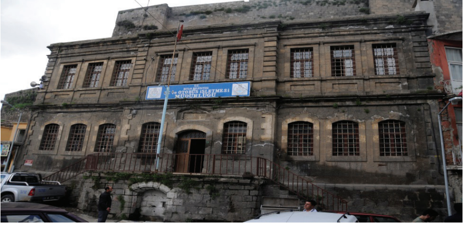
Şekil 27. Bitlis Merkez Belediye Binası Genel Görünüşü (Öztürk, 2018).
