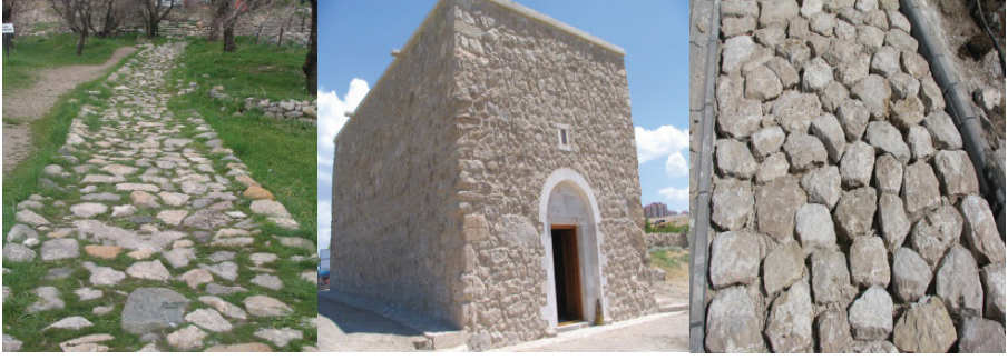
Şekil 44-46. Moloz Taşı Zemin Yol Döşeme Kaplaması ve Duvar Yapım Görünüşleri (Öztürk, 2008).
