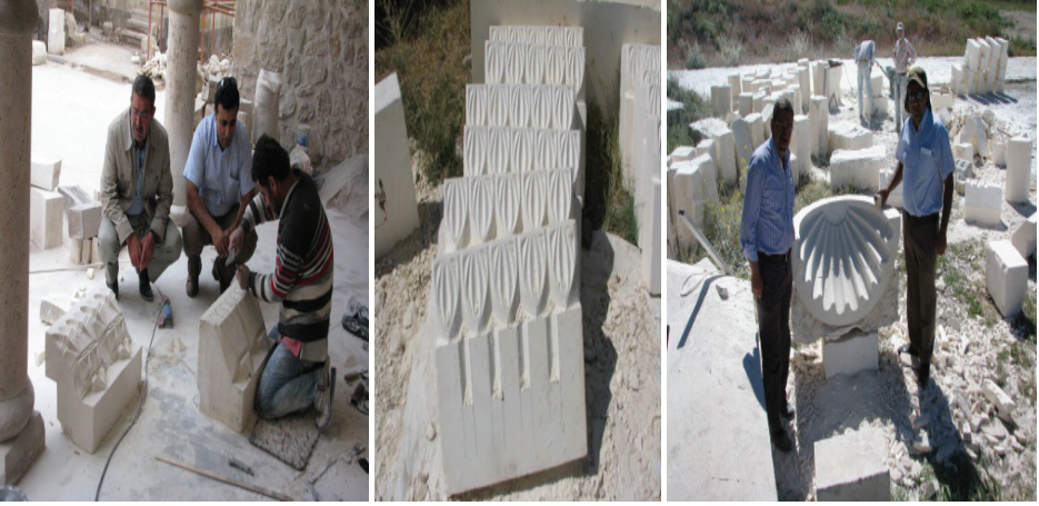
Şekil 23-25. Van/İpekyolu Hüseyin Paşa Camii ve Horhor Camii Mihrap Onarımı Kalker Taş Kullanım Görünüşleri (Öztürk, 2009).
