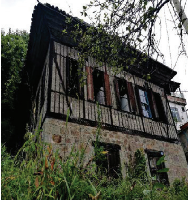
Şekil 4. Bağdadi yapım sistemi örneği
