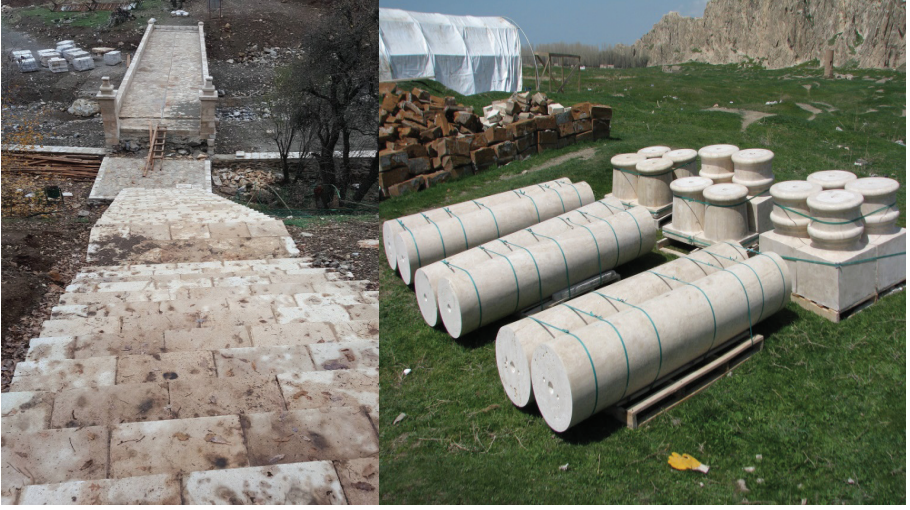
Şekil 7.8. Hakkâri/Şemdinli Şeyh Taha Türbesi Yolu ve Van/İpekyolu Kaya Çelebi Camii Traverten Taşı Sütun Yapım Görünüşleri (Öztürk, 2013-17).
