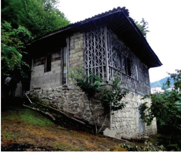
Şekil 5. Karma yapım sistemi örneği
