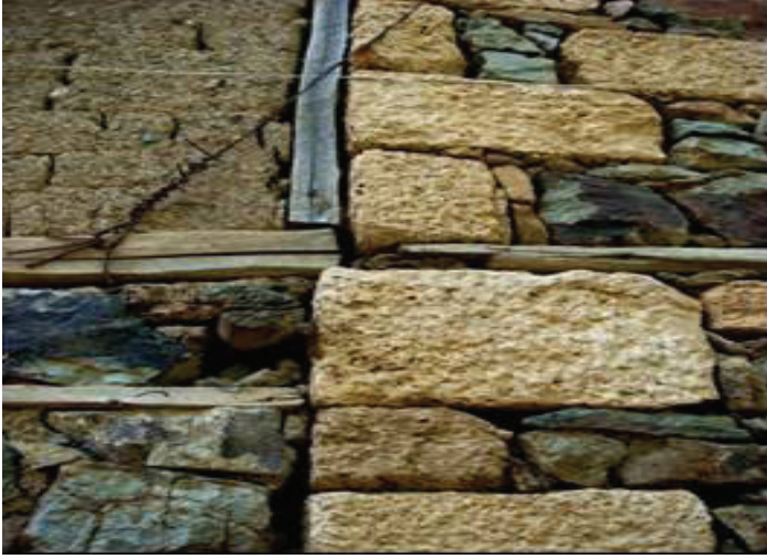
Şekil 4. Taş - kerpiç duvar köşe birleşimi
