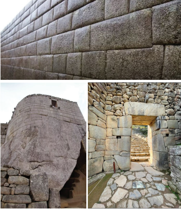
Şekil 23. Machu Picchu şehrinde taş kullanımı örnekleri, a) duvar örgüsü (Url 11) b) Güneş Tapınağı'nın eğrisel duvarları (Url 11) c) duvar örgüsü, zemin kaplaması, lento uygulaması ve kapı açıklığı (Url 13).
