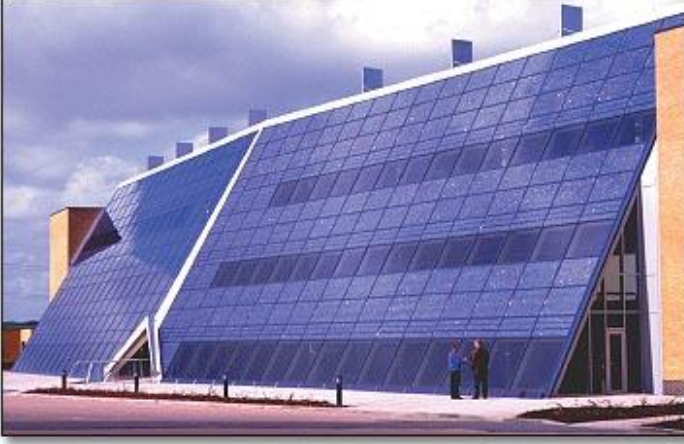
Şekil 5.Doxford International Business Park Binasının Fotovoltaik Cephe Modülleri
