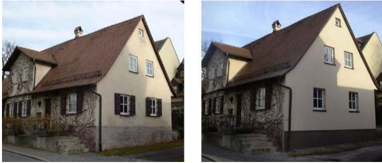
Şekil 27. Yapı cephesinin yenileme öncesi ve sonrası durumu (Binz vd., 2005).
