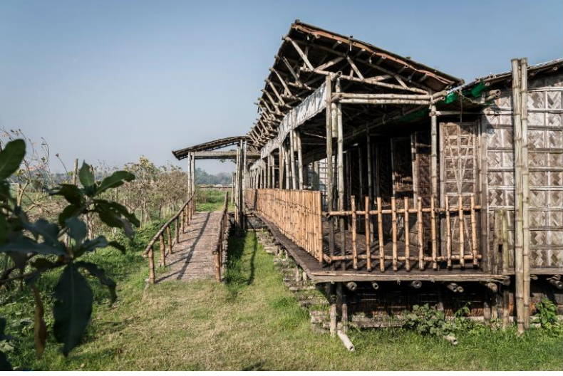
Şekil 5. Giriş Rampası (URL 7).
