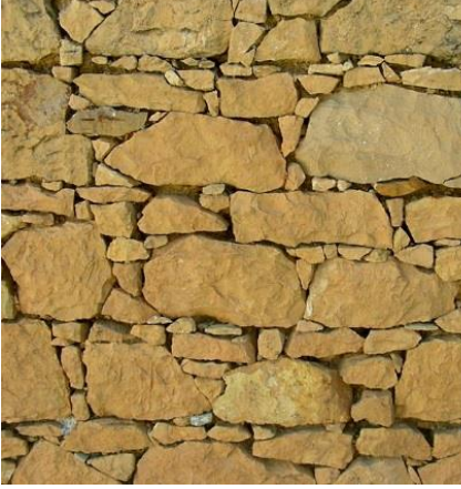
Şekil 14. Kabayonu kuru taş duvar (M.D. Arşivi)
