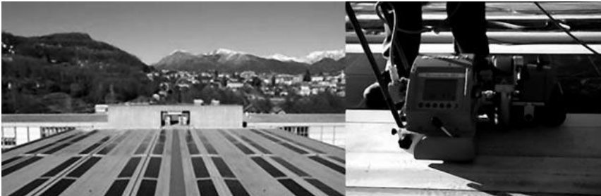
Şekil 35. İnce film fotovoltaik malzeme uygulaması (Pagliarovd. , 2008).
