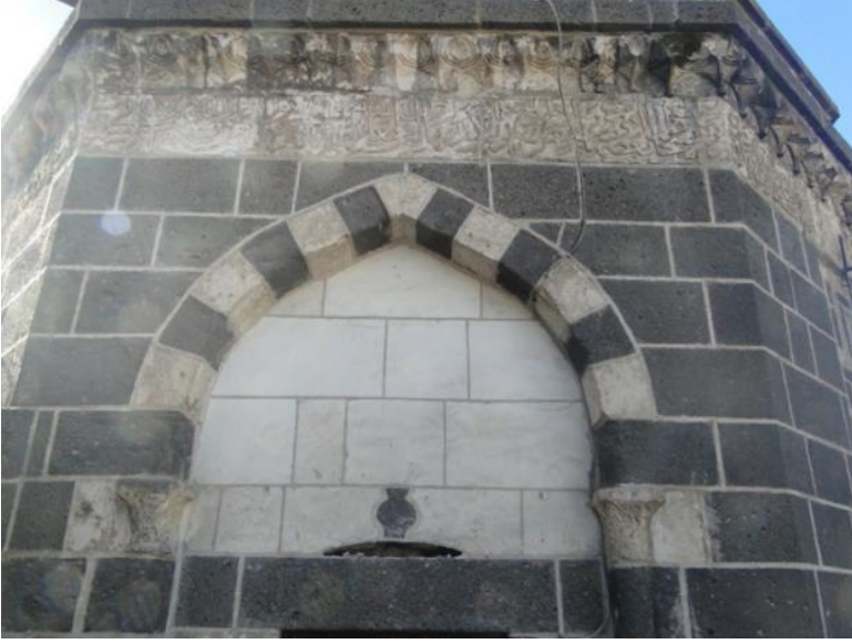
Şekil 26. Diyarbakır Sarı Saltuk Cami bazalt ve kalkerden sivri kemer (M. D. Arşivi)
