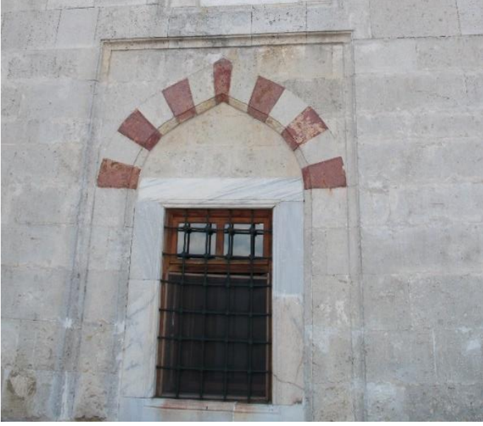
Şekil 23. Edirne Muradiye Camisinde lento üzerinde kemer uygulanması (S. Y. Arşivi)
