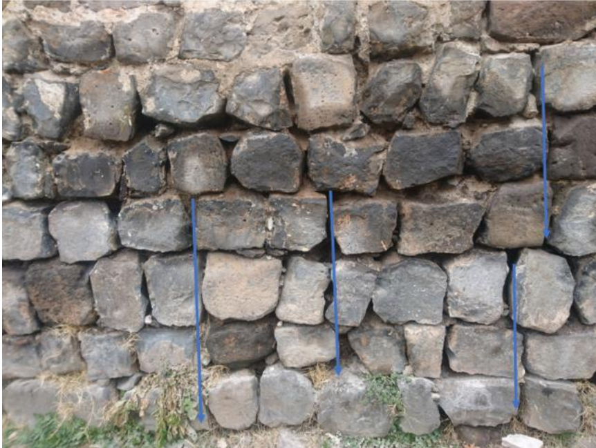
Şekil 21. Tekniğine uygun örülmemiş taş duvar (M.D. Arşivi)
