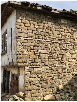
Şekil 12 a. Ahşap hatıl kullanımı
