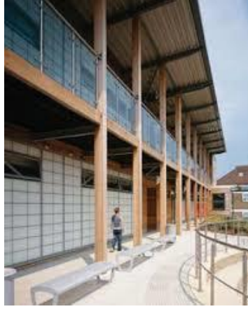
Şekil 19. Highcrest okul binasının arojel cam cephesi (URL-8).
