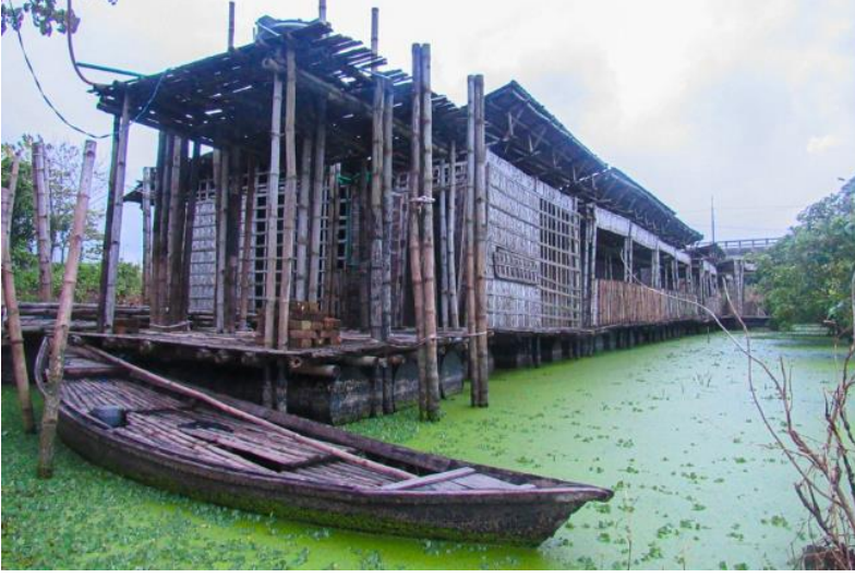
Şekil 7. Sular Yükseldiğinde Yapı Görünümü (URL 8).
