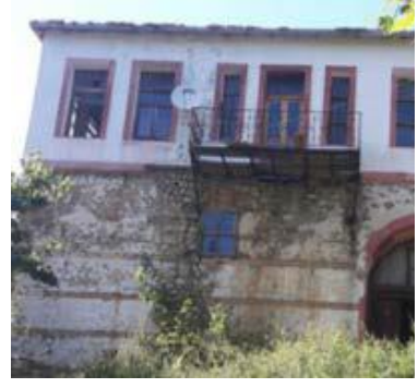
c. Metal hatıl kullanımı (S. Y. Arşivi)
