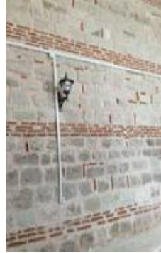
b. Tuğla hatıl kullanımı
