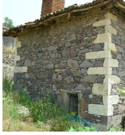
Şekil 19. Cephede moloz ve kabayonu taş duvar (M.D. Arşivi)
