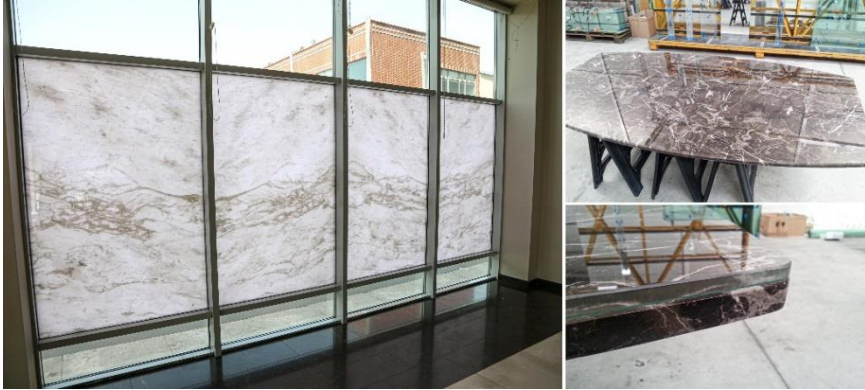
Şekil 16. Solda cam ile lamine edilmiş doğal taş malzeme uygulaması (URL-15). Sağda masa tablasında cam ile lamine edilmiş mermer kompozit uygulaması (URL-16)
