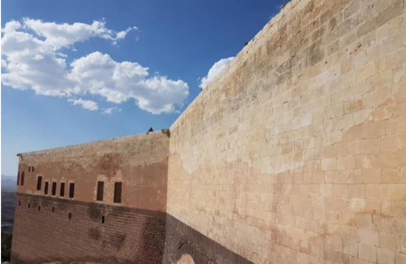
Şekil 20. İshak Paşa Sarayı kesme taş duvar uygulaması (M.D. Arşivi)
