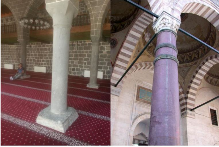
Şekil 22 a, b. Düşey taşıyıcı olarak farklı renklerde taş sütun kullanımı (M.D. Arşivi)
