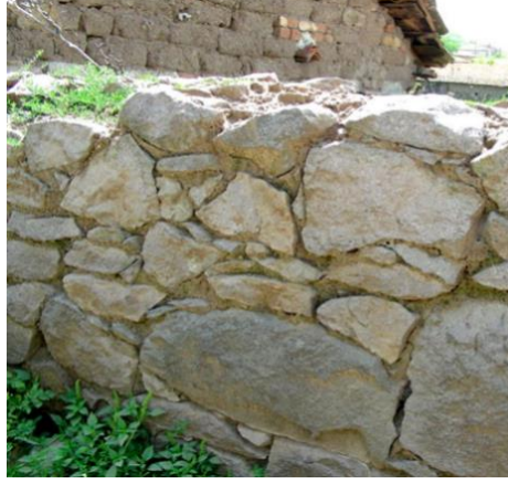
Şekil 15. Kabayonu harçlı taş duvar (M.D. Arşivi)
