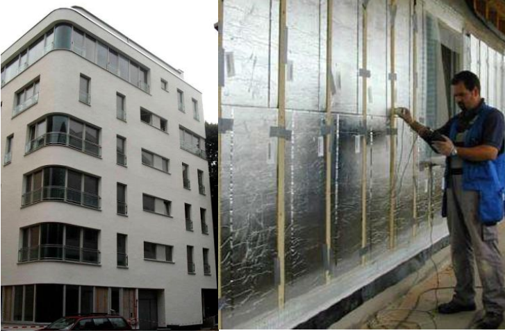
Şekil 25. Seitzstrasse binası genel görünümü ve cephesinde kullanılan vakumlu yalıtım panelleri (Binz vd., 2005).
