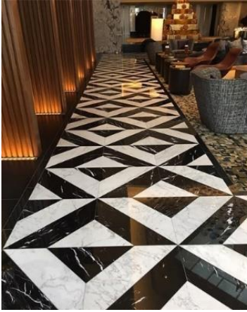
Şekil 17. Porselen çekirdek dolgu ile meydana getirilmiş doğal taş kompozit malzeme ile iç mekan zemin uygulaması örneği (URL-17).
