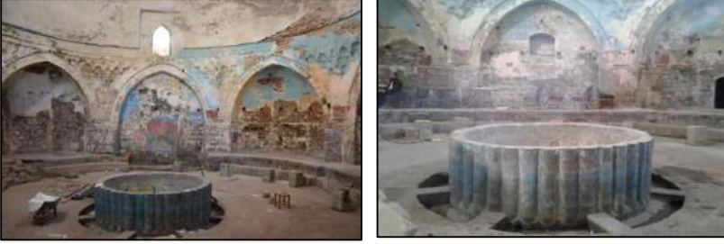
Şekil 6: Soğukluk Bölümünde Bazalt Malzemeden Yapılmış Dilimli Havuz
