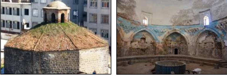
Şekil 4. Deva Hamamı Soğukluk Bölümü Duvarlarında Kullanılan Taş Malzeme (2020)
