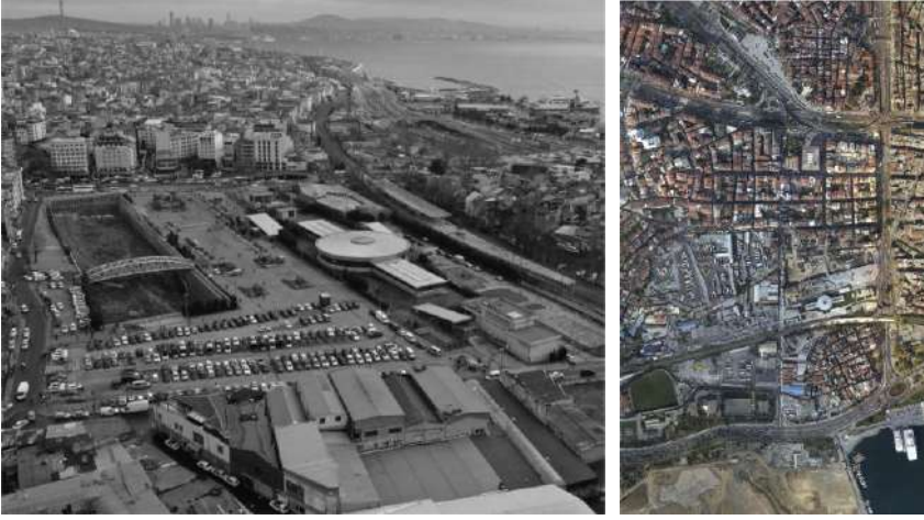
Şekil 18, 19: İstanbul Yenikapı Metro İstasyonu (URL 26)
