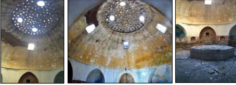
Şekil 8: Deva Hamamı Sıcaklık Bölümü Tuğla Malzemeden Yapılmış Kubbe Ve Filgözleri
