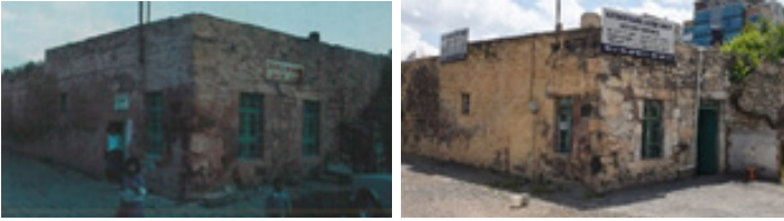
Şekil 20: Deveci hamamı kuzey cephesi (Denktaş, 2000, s. 463; Güler, 2023)
