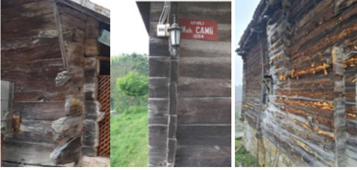
Fotoraf 14-15-16: Duvarlarda kullanılan kurt boğazi köşe geçme detayları: Göğceli Cami, Afırlı camii, Kurtluköyü camii (url-2, Bayhan,2014, S.İşıldak arşivi,2023)
