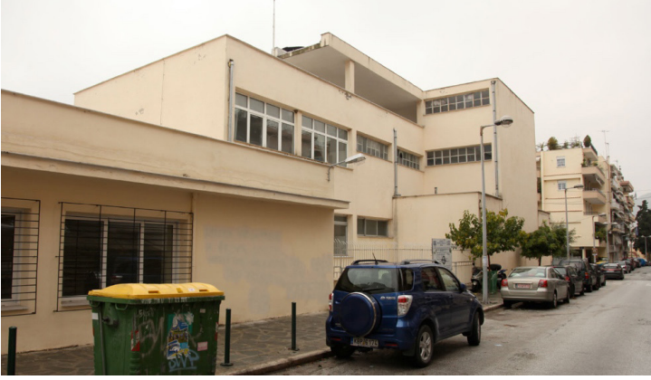
Şekil 12. 2. İlkokul kuzey yönü mevcut durumu.
