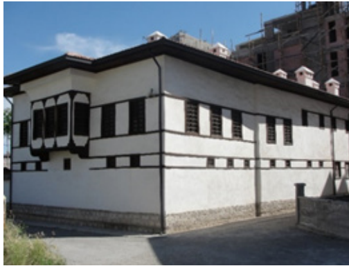
Şekil 11. Karakaş konağı güney batıdan genel görünüşü
