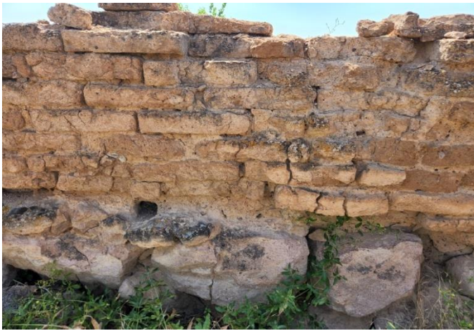
Fig. 10. Kerpiç duvarlar (Foto by T. Öğreten).
