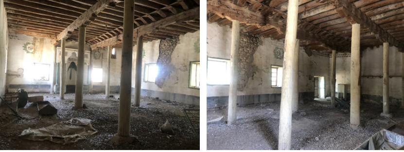
Fotoğraf 1-2: İç Mekan Mihrap Duvarı ve İç Mekan Giriş Kapısı-Taşıyıcı Direkler (D.Mert Kahraman arşivi, 2021)
