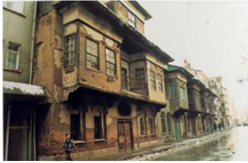
Şekil 19. Beşkonaklar kerpiç duvarlar (restorasyon öncesi) (Bahçeci arşivi)
