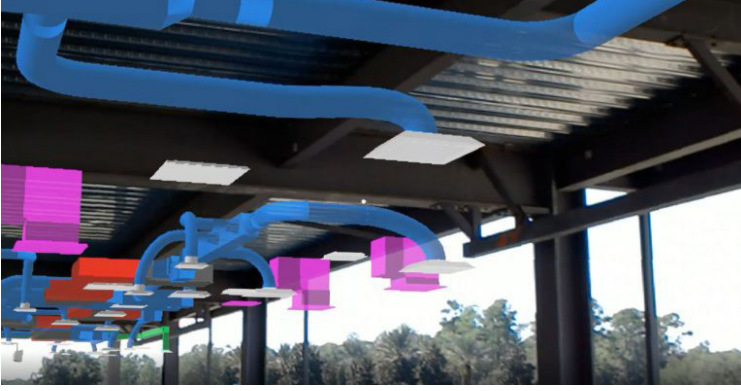
Resim 2. Kask ve gözlüklü AG uygulamasının imalat alanında kullanımı (Food for Thought, 2024)
