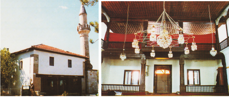
Şekil 22. Köseyusuflu Köyü Camii'nin kuzey cephesi ve mahfil katı (Acun, 2005: 344-5)
